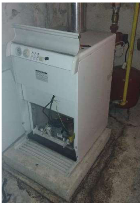
Obrázek 8: Zdroj tepla 1 – kotel na zemní plyn v suterénu.
