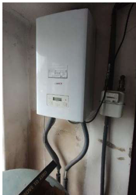
Obrázek 9: Zdroj tepla 2 – kotel na zemní plyn v sušárně.
